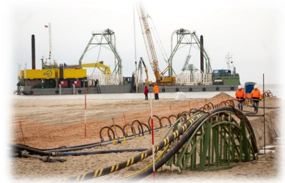
Anlanden von Kabeln auf Nordenei
