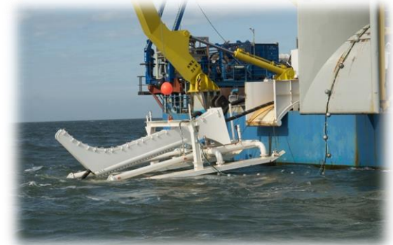
Spülschlitten zum Einspülen der Kabel am Meeresboden
