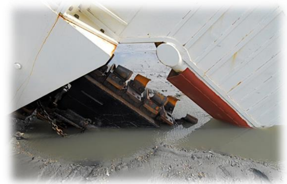
Einfräsen von Kabeln in den Wattboden
