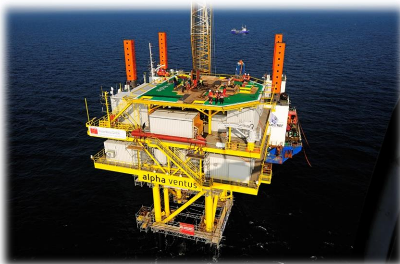
Offshore Umspannstation alpha ventus
