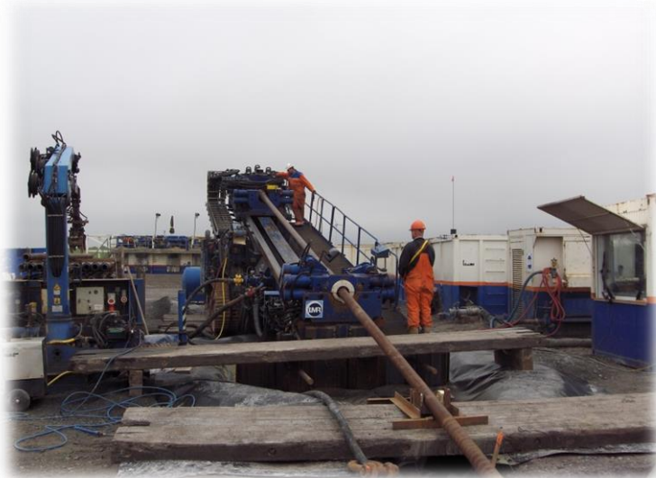
Horizontalbohrung zur Kabelverlegung
