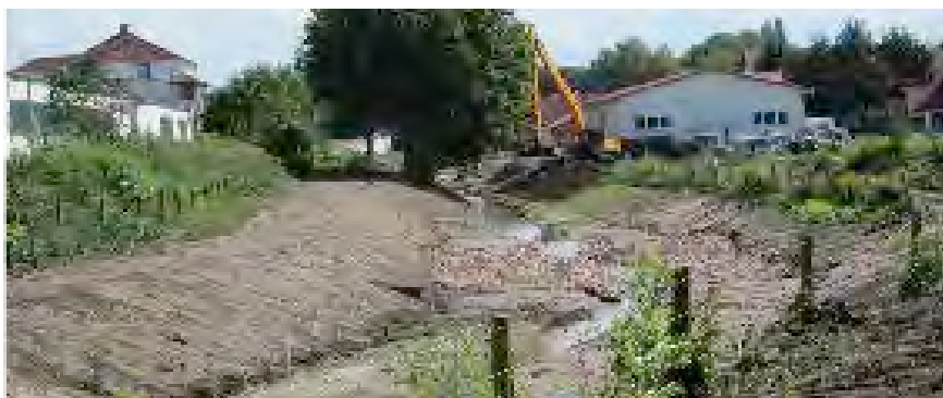
Baustelle des Lippeverbandes – Errichtung des Klimakorridors Kamen
