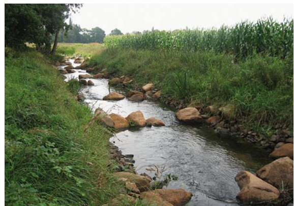
Eine neue Sohlgleite bei Niedrigwasser an der Lindenaer Mühle
