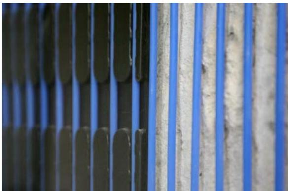
**Abb. 8:** Ausschnitt der verlegten Kapillarmatten in den Wänden von Haus III – Geothermieanlage. Foto: Euler (2010)
