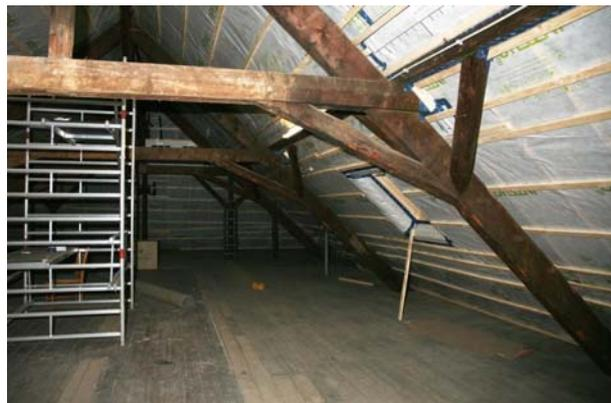
**Abb. 12:** Wärmedämmung Haus I hier Dachlattung. Foto: Euler (2011)
