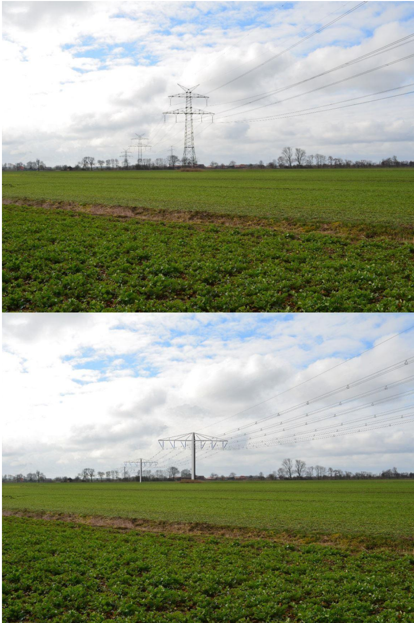
Abb. 14: Vergleich Mehrebenenmast (oben) mit visualisiertem Kompaktmast im Einebenenmast-Design (unten) aus SCHOMERUS et al. (2015: 9).
