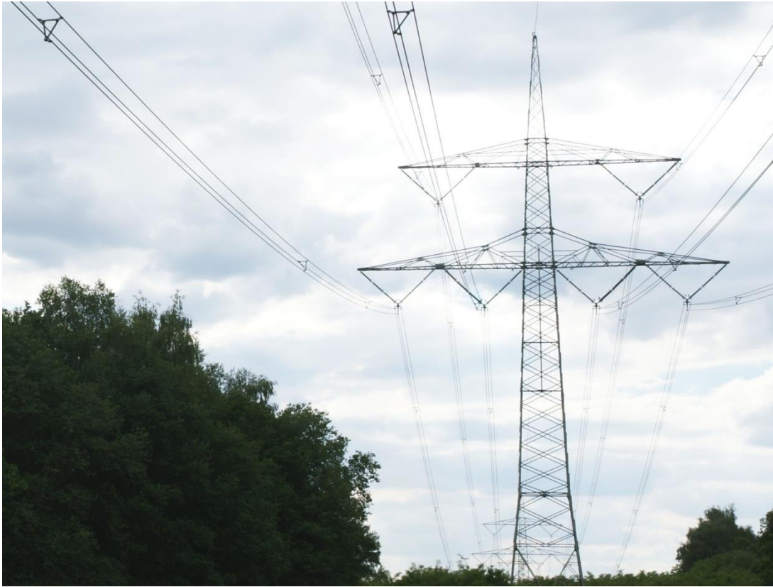
Abb. 15: 380 kV-Leitung bei Barby an der Elbe mit 3er-Bündel (K. FOLLNER).
