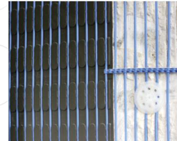
Sichtbare und unsichtbare Energieversorgung: Das große Solarfeld auf dem Dach (oben links) und die Erdwärmepumpe im Keller decken ca. 13% des kompletten Energieverbrauchs aller Gebäude. Die in einem kleinen Bereich offen gehaltenen Heizschlangen verdeutlichen Besuchern das Wirkprinzip der Geothermieanlage.
