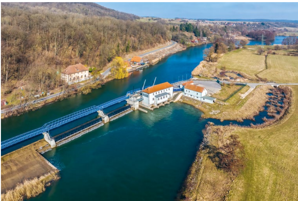
Wasserkraftanlage Hausen am Obermain mit 600 kW Leistung: Stauwehr, Maschinenhaus und Fischpass für den Fischaufstieg
