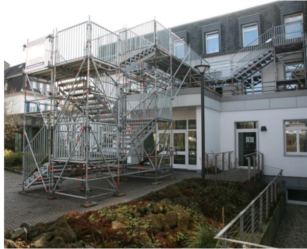
Abbildung 3: Bautreppenturm – Treppenhausrenovierung (Euler 2015)
