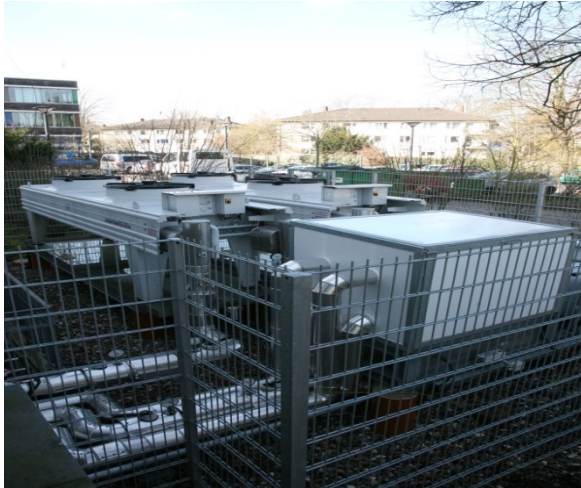
Abbildung 2: Klimageräte zur Kühlung der Serverräume (Euler 2015)
