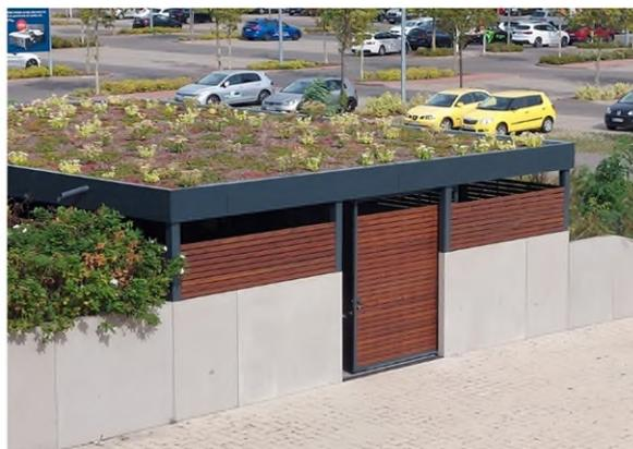
**Abb. 23:** Mülleinhausung mit Gründach: links Ansicht von oben, rechts Ansicht vorn (Fotos Katrin Fritzsching 2023)
