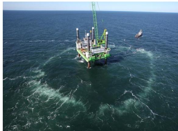
Abb. 14.: Beim Rammen der Windkraft-Fundamente entstehender Unterwasserlärm kann durch den Einsatz von Blasenschleiern minimiert werden (li. Foto Klaus Betke; re. Foto Trianel).
