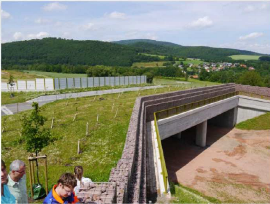
Querungshilfen - Beispiel Autobahn 44
