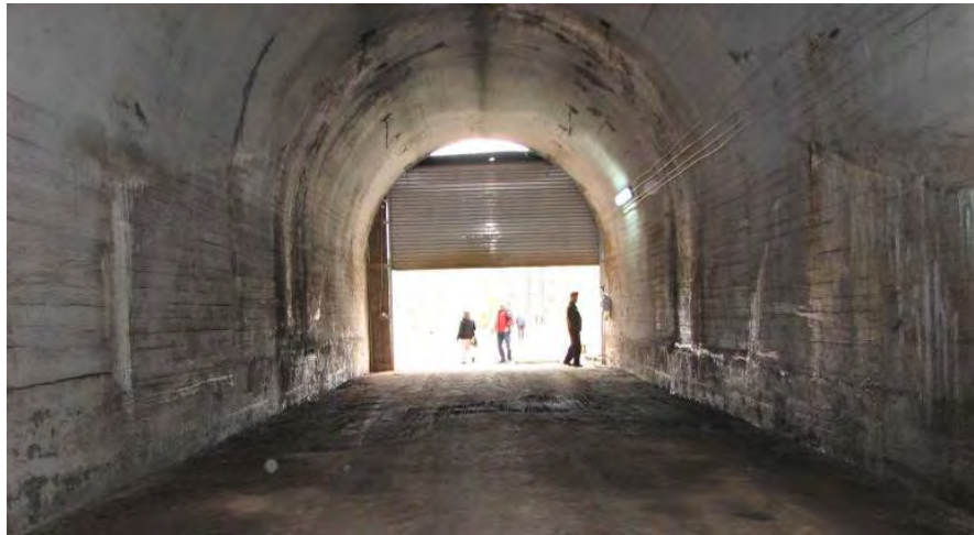
Abb. 14: Das Eingangstor bleibt im oberen Teil für Fledermäuse passierbar
