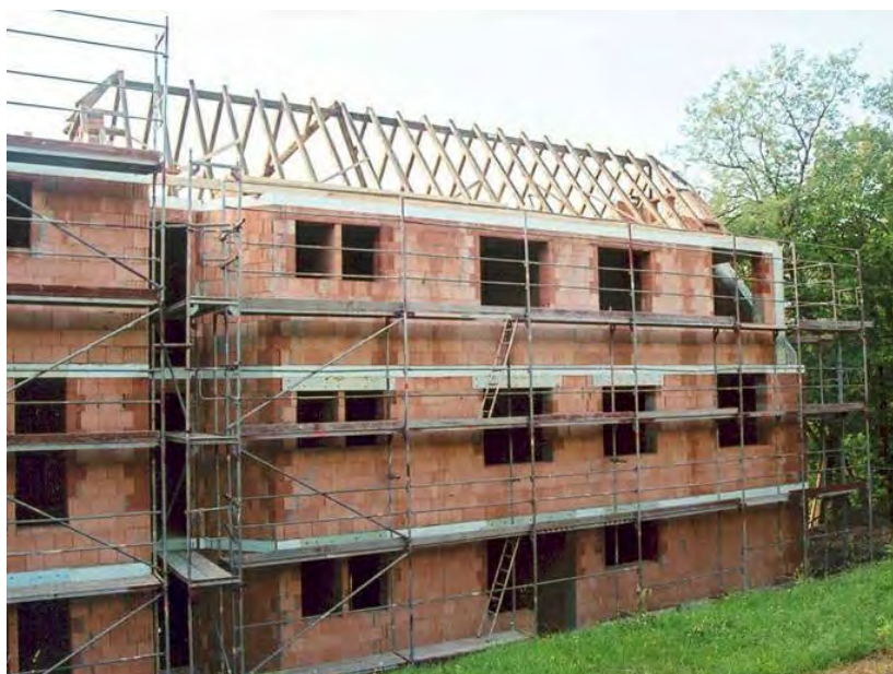
Abb. 18: Mehrfamilienhaus in Jena Sophienhöhe im Rohbau. An der Farbe der Dachbalken erkennt man, dass es sich um den alten Dachstuhl des Vorgängerbaus handelt.
