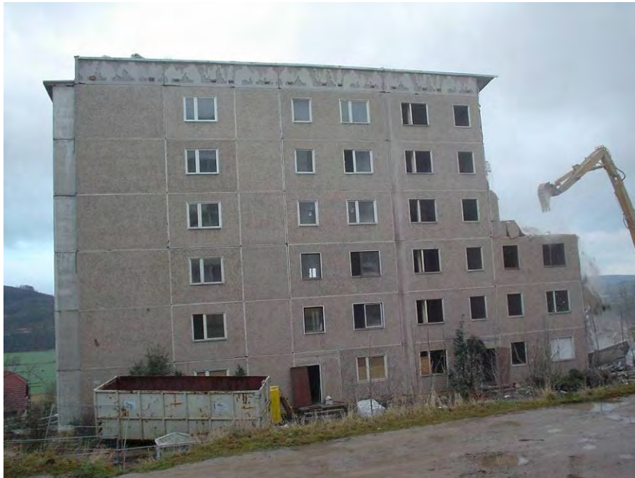
Abb. 21: Der Wohnblock während der Abrissarbeiten.
