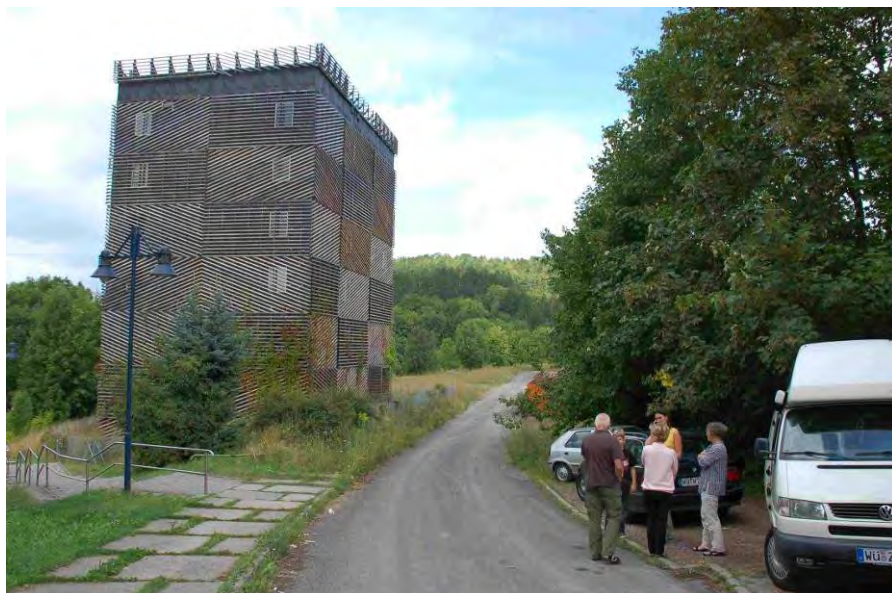
Abb. 22: Der Fledermausturm nach der Fassadenverkleidung.
