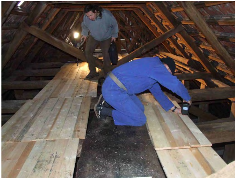
Abb. 9: Die Quartierbetreuer ziehen auf den Dachbalken Kotbretter ein. Die jährliche Kotberäumung wird dadurch erleichtert und die Absturzgefahr durch die verbreiterte Lauffläche verringert.
