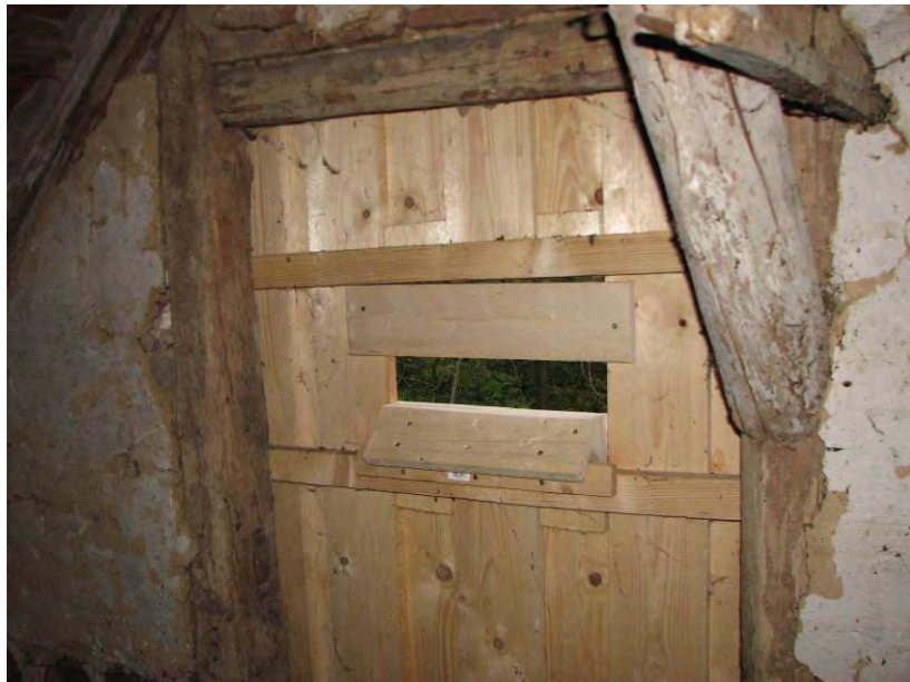
Abb. 17: Eine der neuen Einflugöffnungen in der Wiesenmühle.
