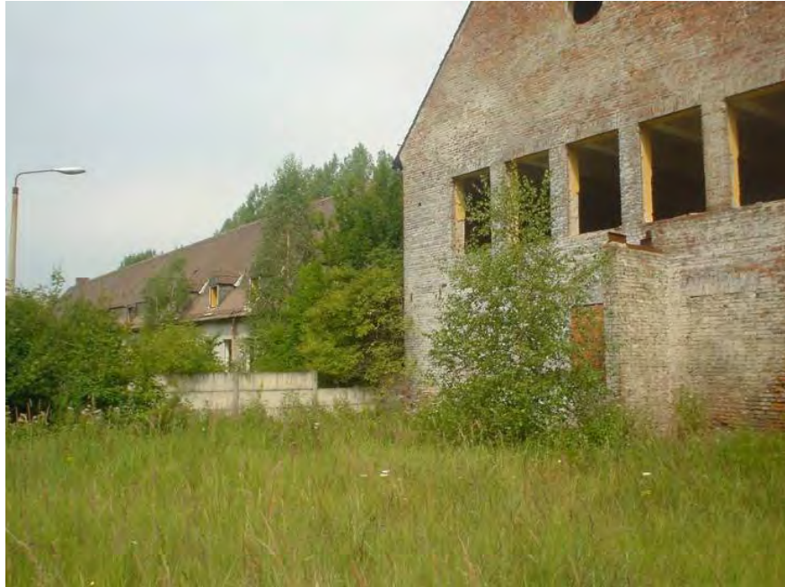
Abb. 29: Kaserne vor der Renaturierung.
