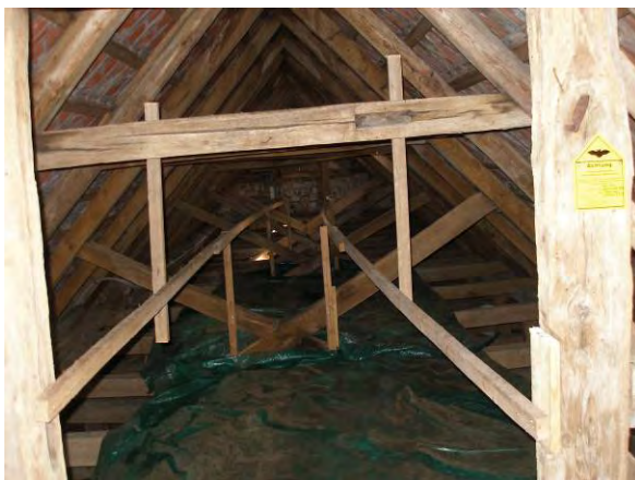
Abb. 10: Nach Abschluss der Bauarbeiten.
