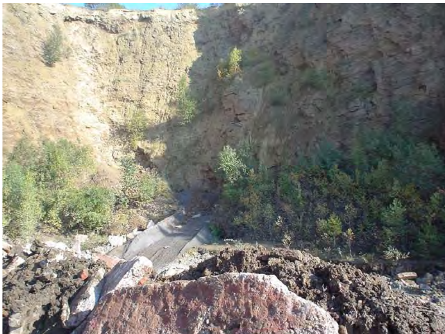
Abb. 20: In dieser Wand (hinter dem Gebüsch) befinden sich die Eingänge zu den Stollen. Im Vordergrund wurde bereits Massen zum Verfüllen angeliefert.
