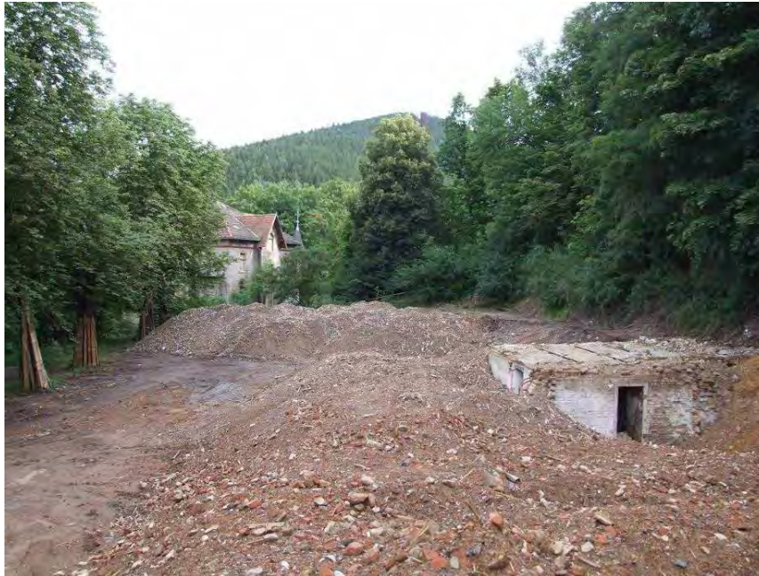
Abb. 27: Sanatorium Sommerstein nach dem Abriss. Im Hintergrund die „Villa“, die erhalten werden musste.
