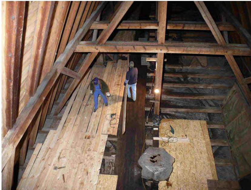
Abb. 12: Über dem Tonnengewölbe der Kirche in Ershausen wird ein Zwischenboden eingebaut.
