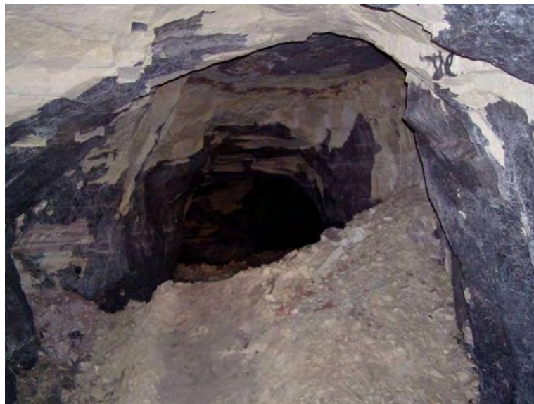
Abb. 25: Schwarzer Pulverschmuck der Sprengung der Stollen nach dem Krieg. Der Aufenthalt in den Stollen ist teilweise lebensgefährlich.
