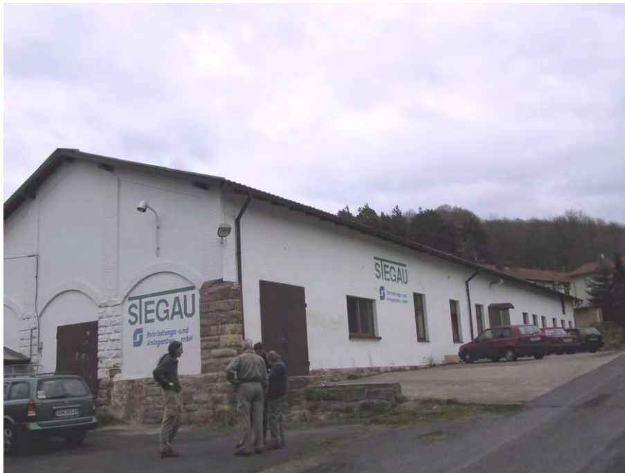
Abb. 1: Dorndorf-Kambachsmühle - Das Quartier der Mausohren befindet sich im hinteren Teil dieses Betriebsgebäudes, welches verkauft werden soll.
