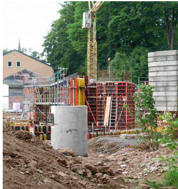
Abb. 8: Schacht mit seitlicher Öffnung. Neuer Einflug der Kleinen Hufeisennase.
