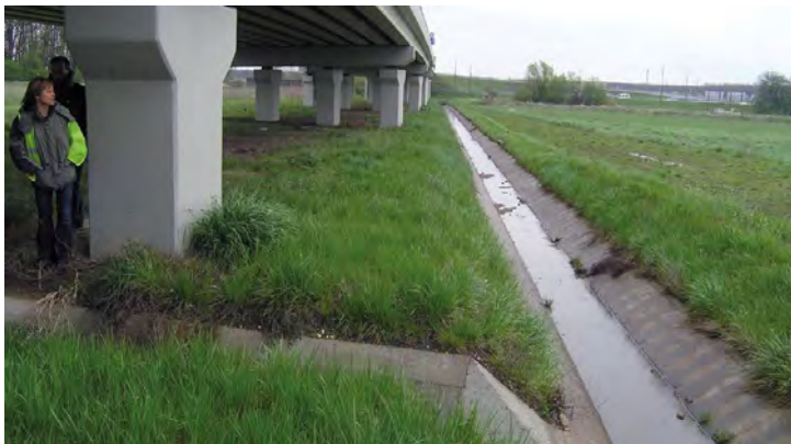
Abb. 33: Verkehrsbegleitende Entwässerungsgräben als Barriere
