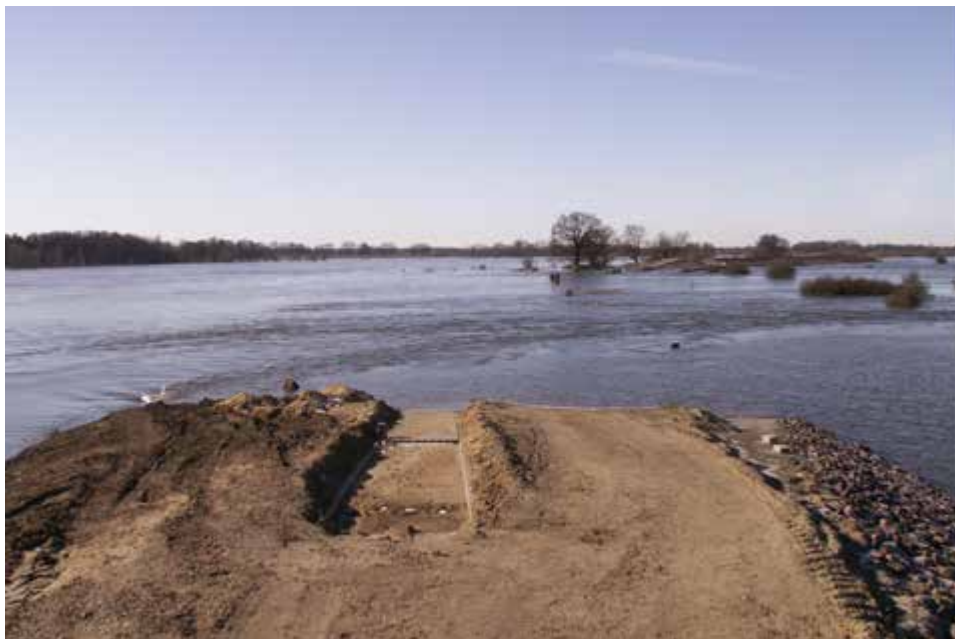
Abb. 37: Die 500 m breite Öffnung des Altdeiches am Bösen Ort ist von erheblicher Bedeutung für dynamische Prozesse im wiederhergestellten Überschwemmungsgebiet (hier noch im Bauzustand 2010). Foto: Trägerverbund Burg Lenzen e.V.
