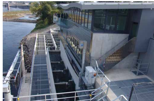
Abb. 7: Moselstaustufe Koblenz – eine erfolgversprechende Pilotanlage zum Fischaufstieg. Für den Fischabstieg dient jedoch eine alte Anlage mit einem Rechenabstand von 15 cm. (Foto: http://www.wasser.rlp.de/servlet/is/8602 )
