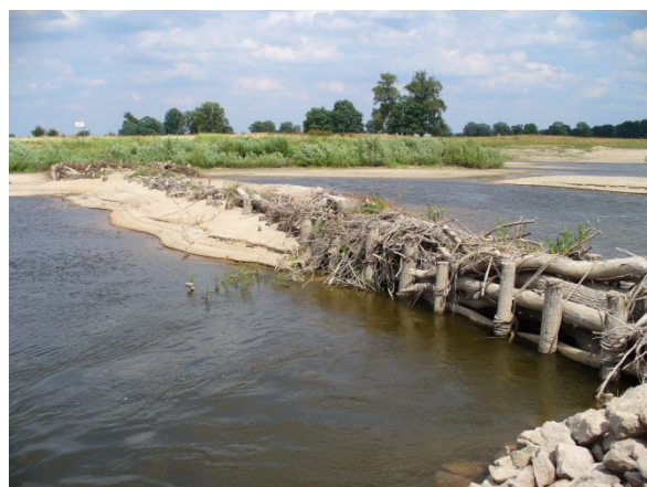
Abb. 4: Totholzbuhne Elbe-km 450,70 bis 451,00. (Fotos: Bildarchiv der WSV)
