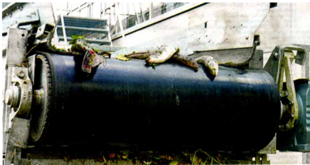
Abb. 6: WKA Kostheim Main, Neubau 2010. (Foto: Kuhn/Hoff-Schramm)
