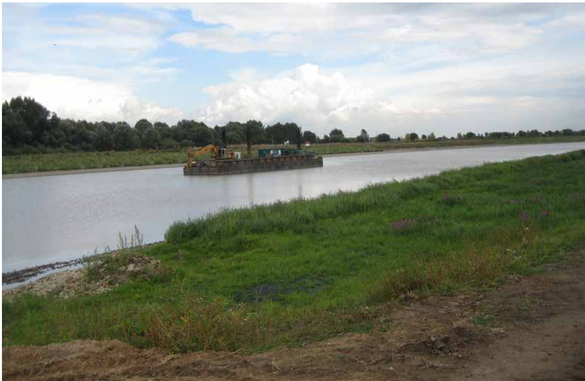
Abb. 32: Im Sommer 2012 fertiggestellte Abschnitte der Flutmulde.
