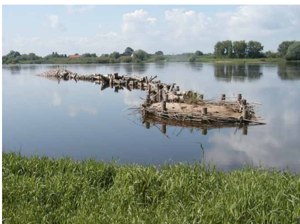
Abb. 4: Totholzbuhne Elbe-km 450,70 bis 451,00. (Fotos: Bildarchiv der WSV)
