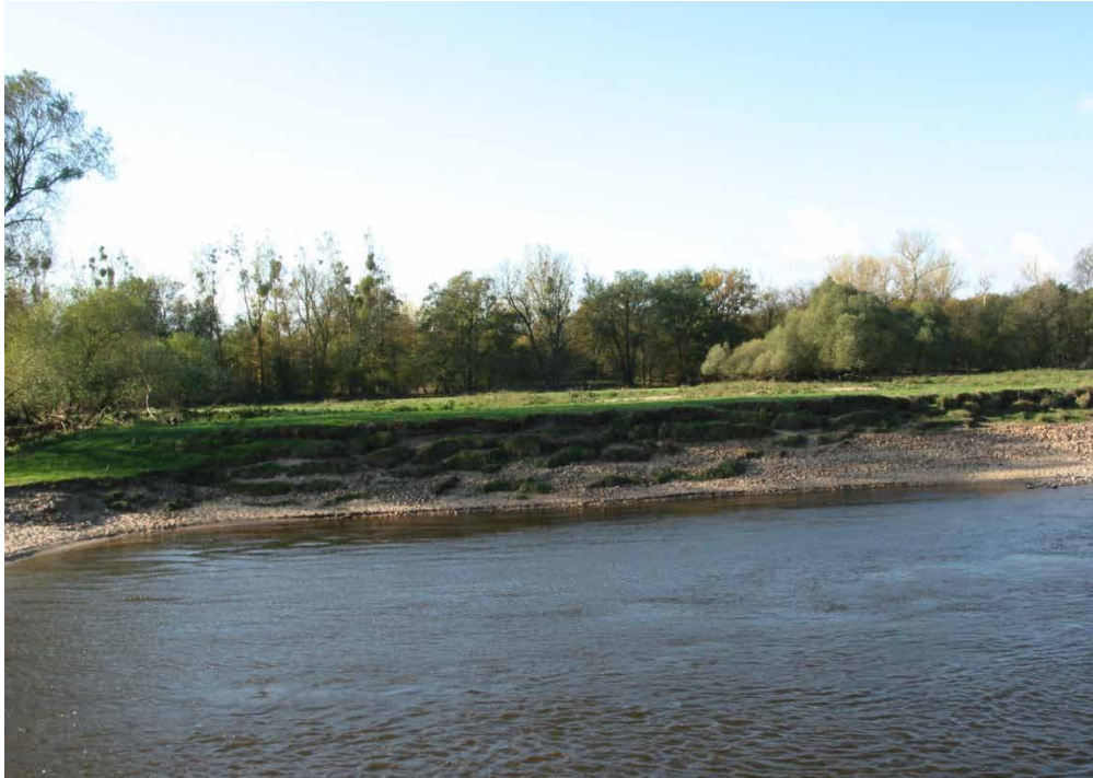
Abb. 3: Rückbau einer gepflasterten Ufersicherung bei Steckby/Lödderitz an der Elbe. (Foto: P. Faulhaber, BAW)
