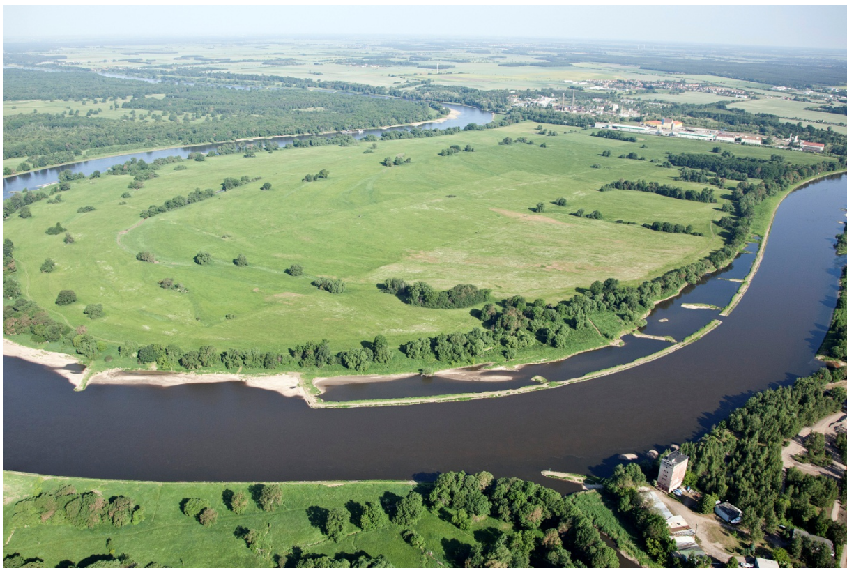
Abb. 5: Instandsetzung eines Leitwerkes bei Dessau (Foto: A. Hilger)
