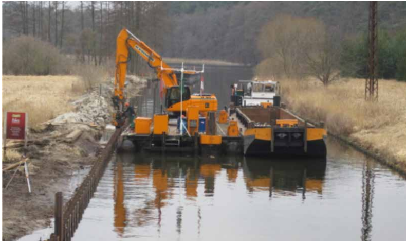
Abb. 9: Schleuse Diemitz. Links neue Stahlspundwände, rechts alte Uferbefestigung aus Holz in wassertouristisch genutzten Gewässern in Brandenburg. (Foto: Bild der Woche, WSA Eberswalde 24.4.2012)
