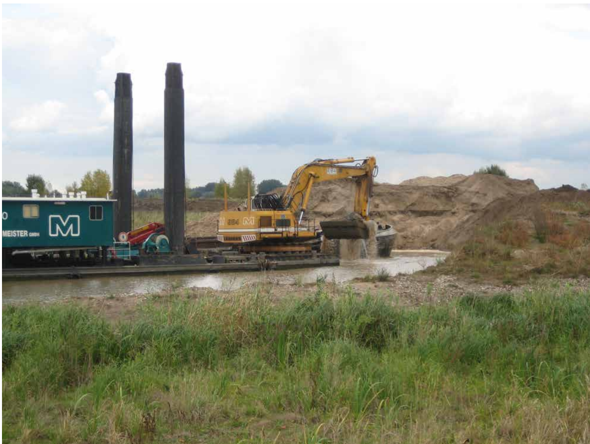
Abb. 31: Stelzenponton mit Hydraulikbagger.
