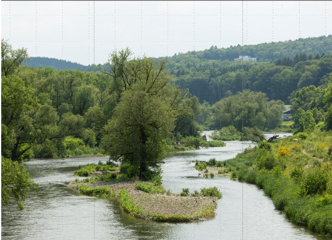
Abbildung 5: Die Ruhr in Arnsberg wurde aufgeweitet, sie kann sich in einem breiten Korridor wieder eigendynamisch verlagern. Der größere Abflussquerschnitt verbessert zudem die Hochwassersituation für die beidseitigen Siedlungsgebiete. Für die Stadt und den begleitenden Ruhrtalradweg bedeutet die neue Ruhr eine enorme Aufwertung.
